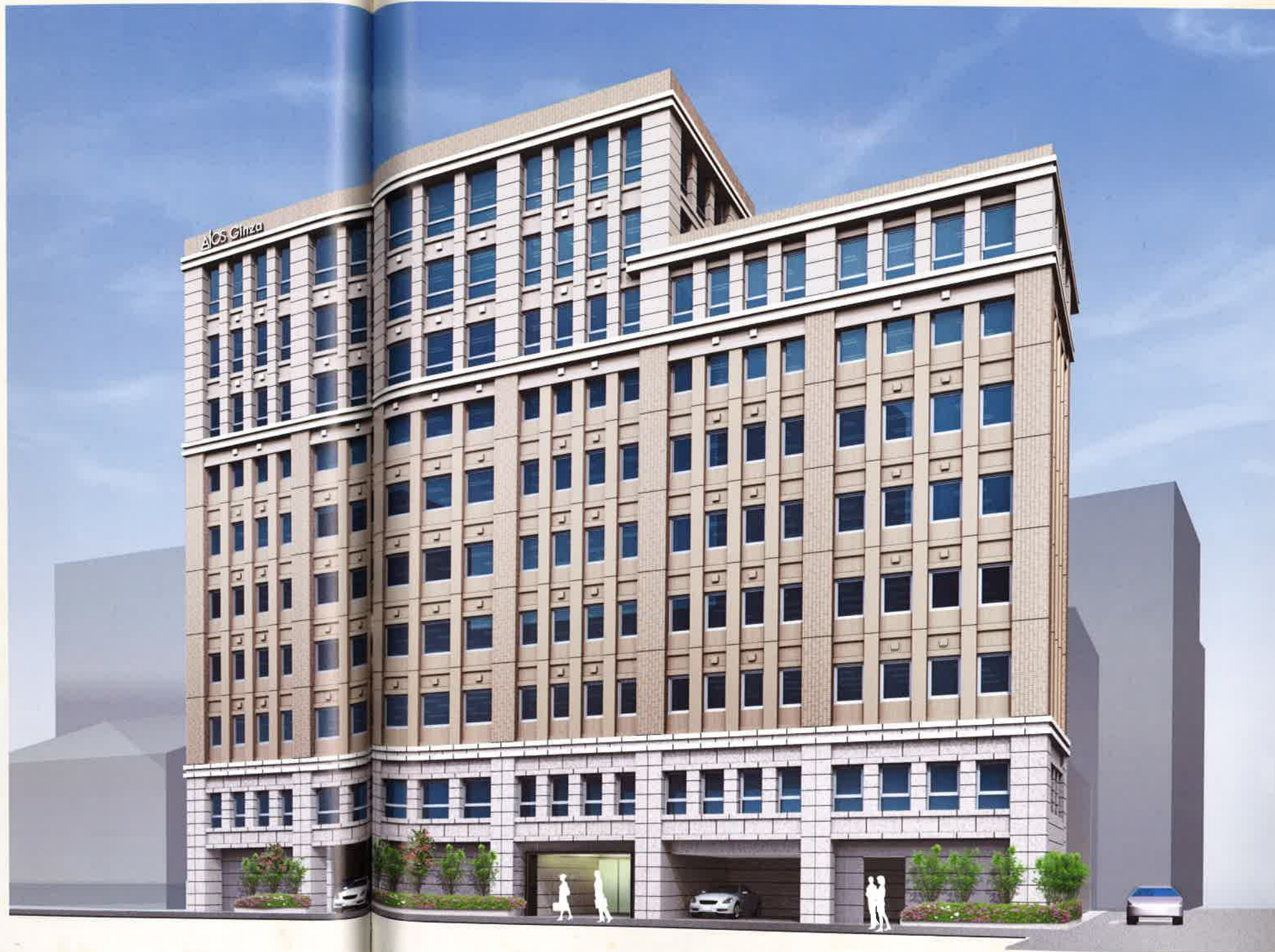
北側ファサード——3層構成の外観は、静かな表情を出しつつ街並みに対して、ヴォリューム感の軽減を計る。
